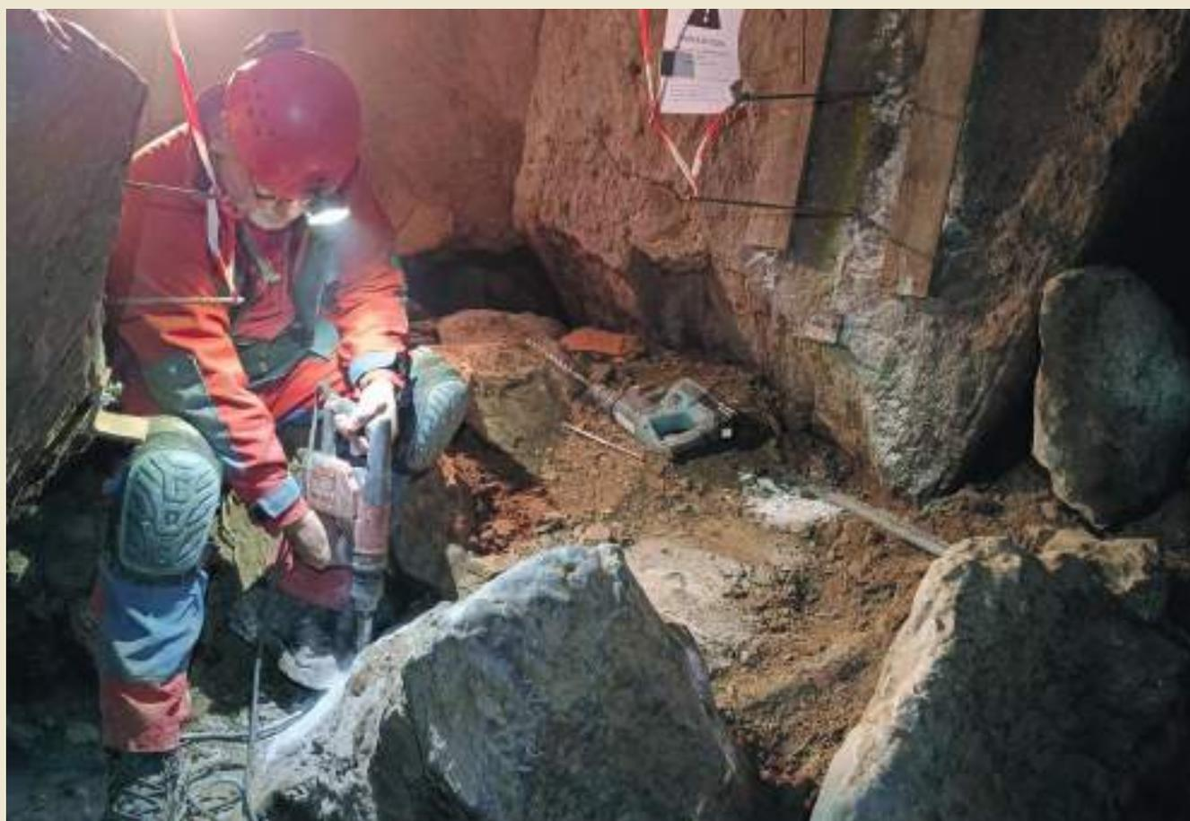
*Yves perce les trous pour les barres d'acier Ø25 pour le passage de l'eau en dessous de la future fermeture..*
